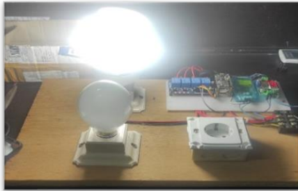
Gambar 33 Kondisi Lampu 1 Menyala
